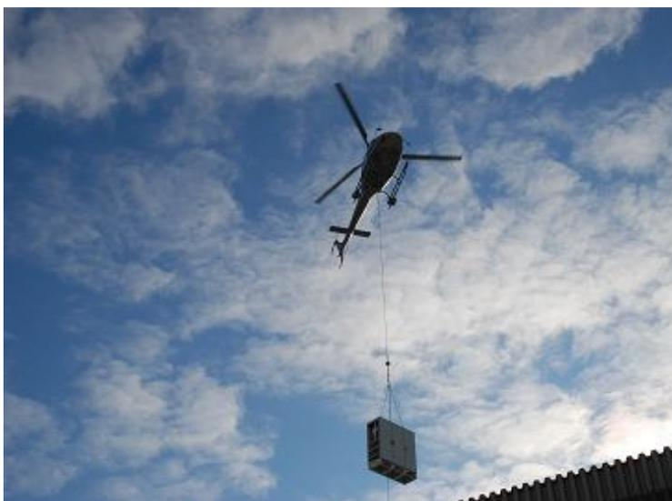
Anlieferung der Systemtechnik einer Digitalfunk-Basisstation aus der Luft
