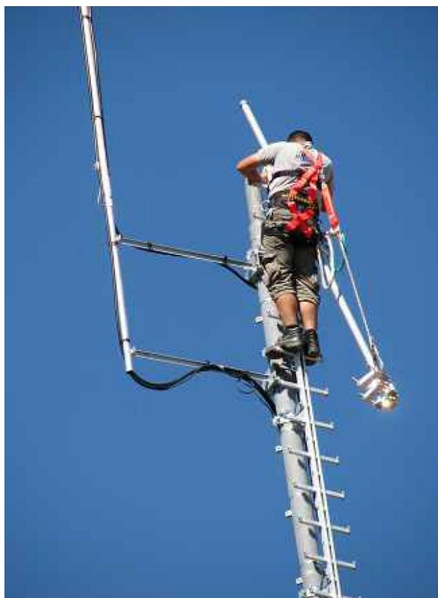
Montage einer Digitalfunkantenne auf einen Funkmast;
